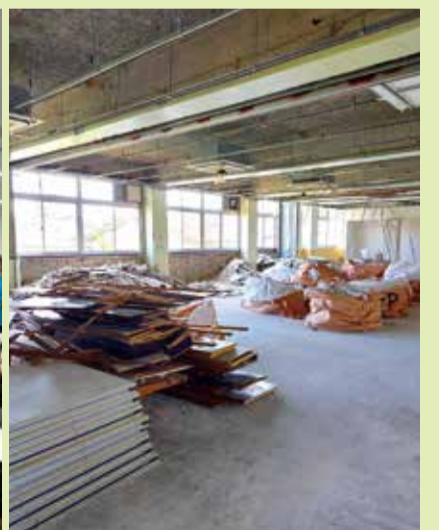
解体工事風景
